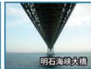
明石海峡大橋
